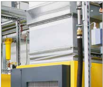
Imagen 2: Conexión de ventilación del compresor con empalme de lona.
