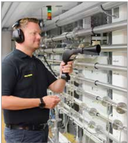
Imagen 4: Localización de fugas con ultrasonidos.
