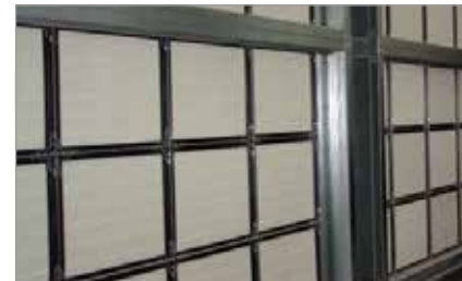
Imagen 2b: Sistema de filtros del aire de refrigeración.
