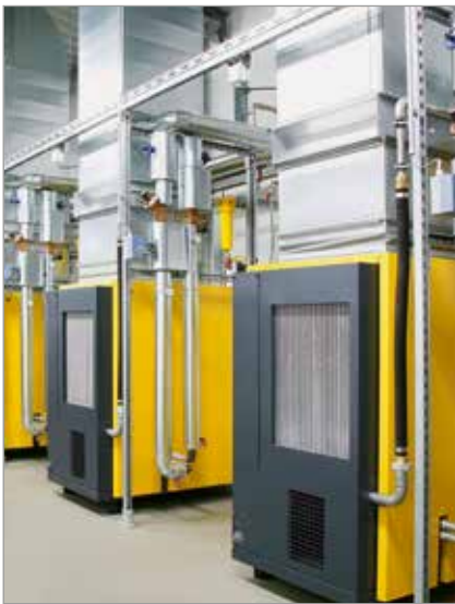
Imagen 2: Conexión de varios compresores a un sistema de recuperación del calor conforme a la normativa.
