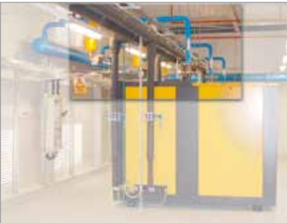
Imagen 3b: Conexión antivibraciones del compresor con compensador axial.
