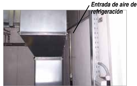
Imagen 2a: Esterillas filtrantes centralizadas del aire de refrigeración.
